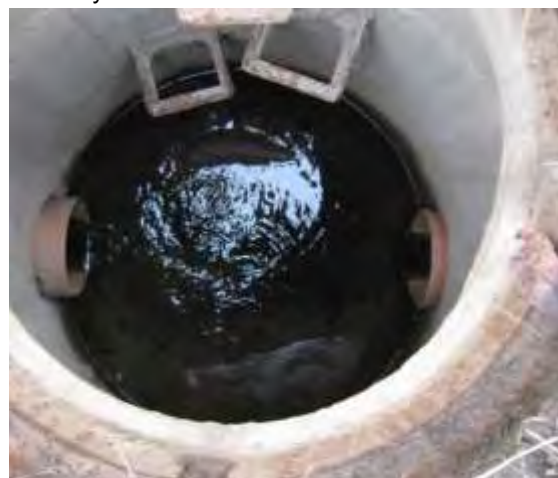
Probenahmestelle einer Abwasserprobe
