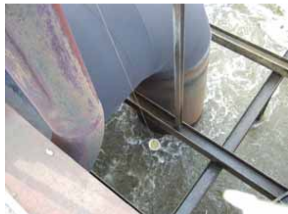
Foto: Probenahme aus Direkteinleitungen
